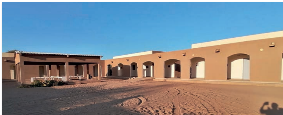
Le centre de soins vue d'ensemble.
